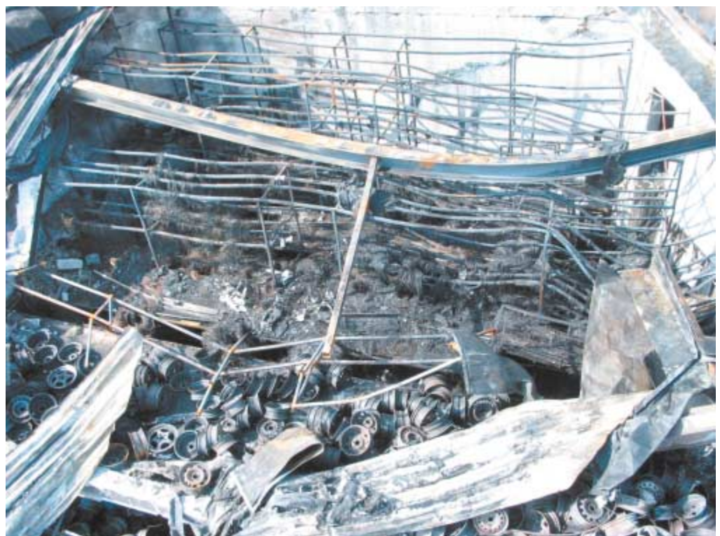
Die Deformierung des Doppel-T-Stahlträgers zeigt, welche enorme Wärme bei Reifenbränden entsteht.
